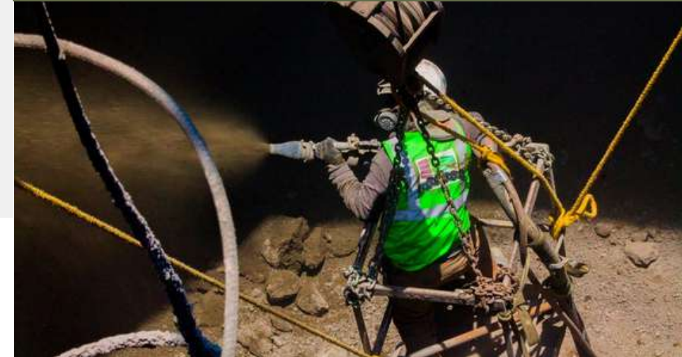
CONCRETO LANZADO
