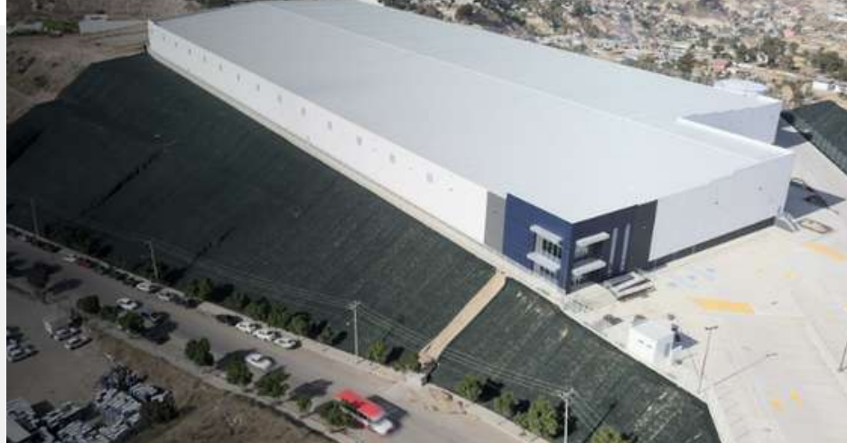
MURO DE CONTENCIÓN
